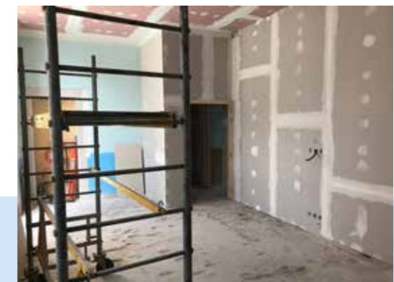
Future salle de bibliothèque/garderie
